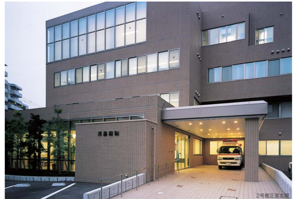
2号館正面玄関
