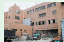
川島病院1号館西側改築工事
