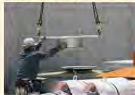
実際の免震ゴムがこちら。この上に新しいクリニックが建ちます。
