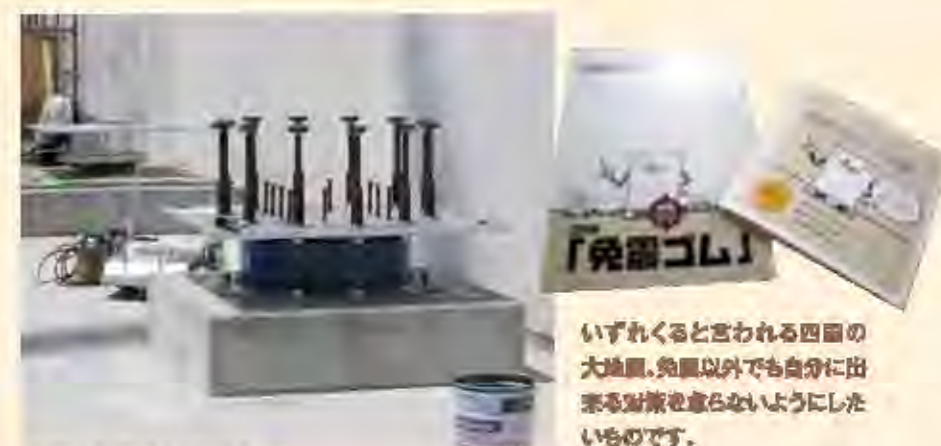
実際の免震ゴムがこちら。この上に新しいクリニックが建ちます。
